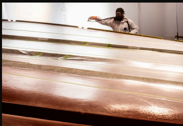
Dekafwerking. Het dek wordt voltooid en voorzien van primerlagen. © Ferrari
